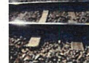
線路設備の修繕
